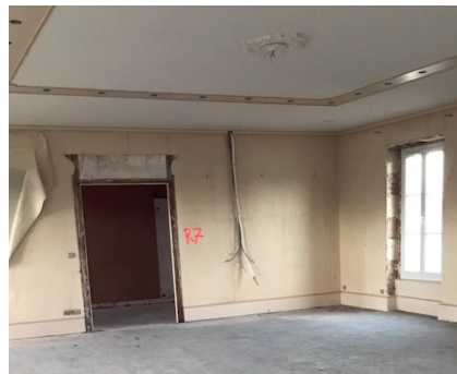
Travaux à l'intérieur de la mairie ↗
