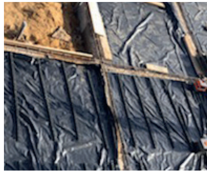
Installation de l'isolation et des grilles de ferrailles. ↗
