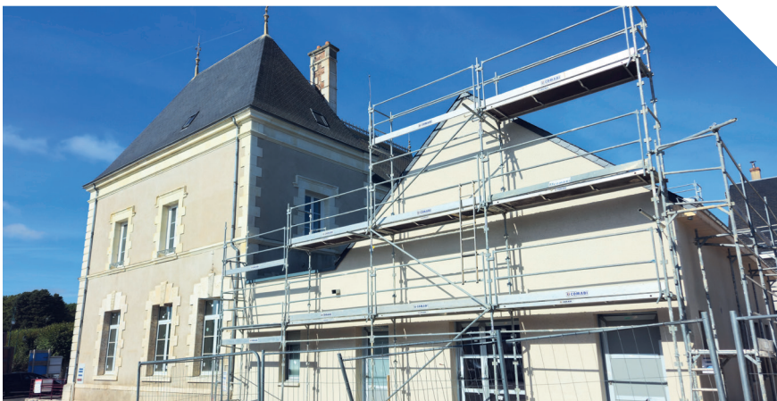
Extension à l'arrière de la mairie destinée à accueillir l'Espace France Services et l'agence postale ↗
