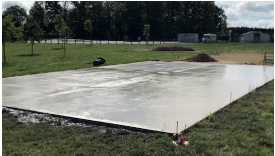
Réalisation d'une dalle de 150 m 2 en béton armé par nos agents municipaux sur l'esplanade de la salle des fêtes
