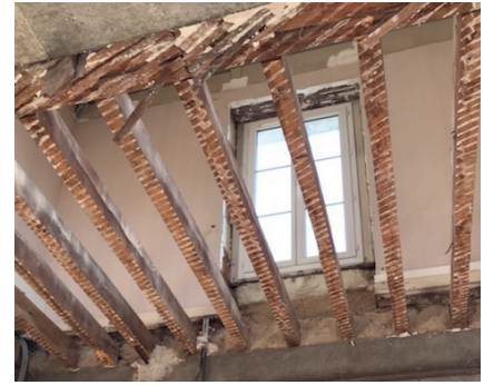
Mise à niveau du plancher haut et renforcement des poutres. ↗
