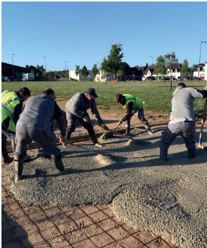
Réalisation d'une dalle de 150 m 2 en béton armé par nos agents municipaux sur l'esplanade de la salle des fêtes
