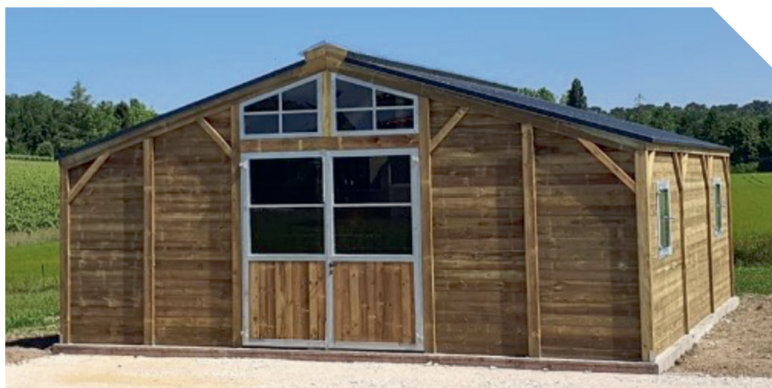
Montage d'un horse barn
